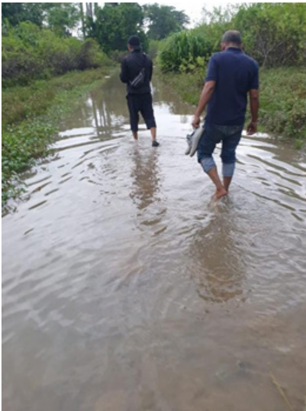
Foto 4. Kondisi jalan menuju SMA Kristen Boking yang tergenang air pasang.
